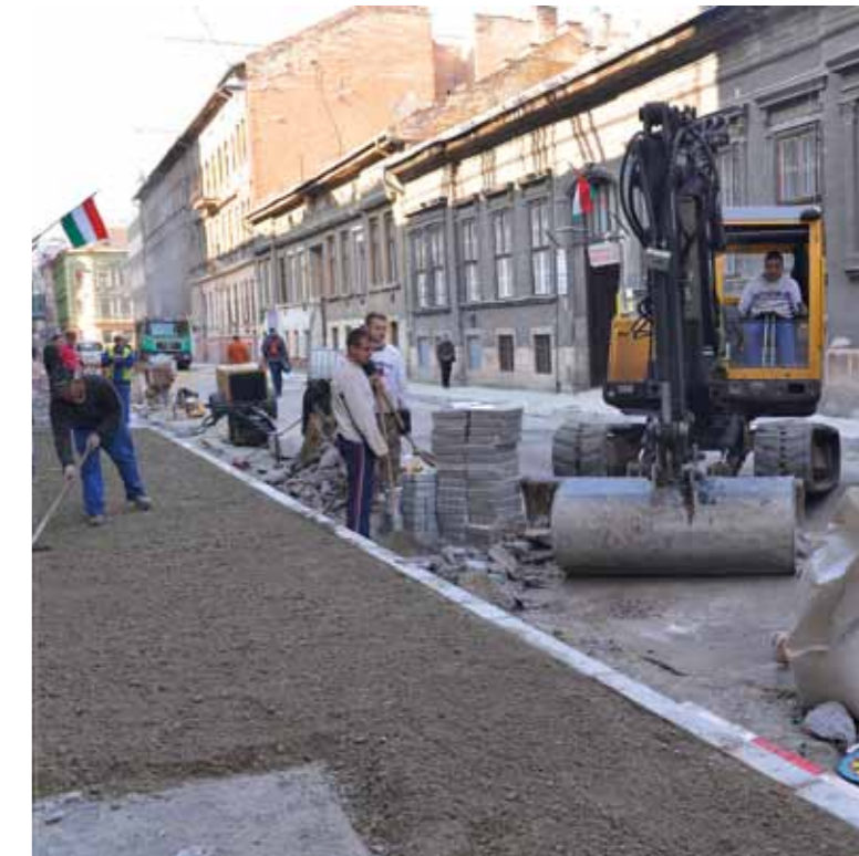
Megkezdődött a Hársfa utca újabb szakaszának rekonstrukciója
