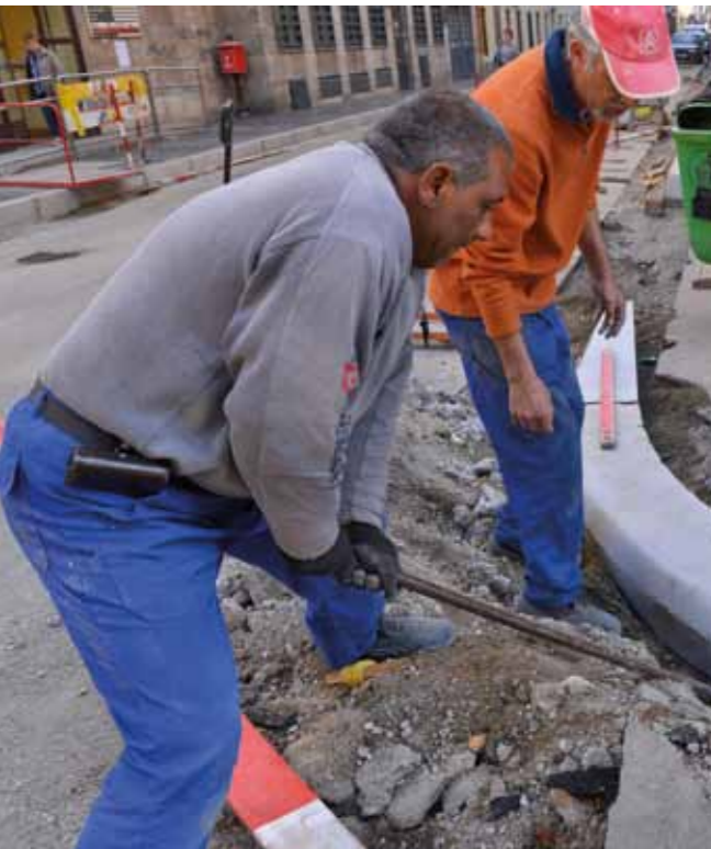
A Hársfa utcában a teljes út- és járdaburkolatot felújítják
